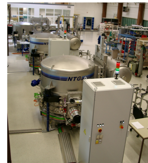
3 IBF 500 Anlagen mit Doppelschleusen
