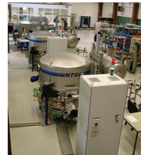
3 IBF 500 Anlagen mit Doppelschleusen
